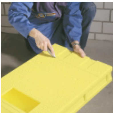
Brzo na 980 mm: skratiti kućište na markaciji prema montažnoj uputi. Cijev za ispiranje skratiti za 150 mm pa nataknuti preko dvostrukog O-prstena.
