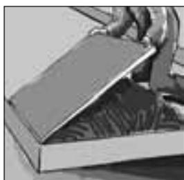
Prvu ploču BA Balco GP s nagibom 20/38 položite uzduž vanjskog balkonskog ruba.
