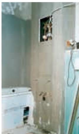
Isporučeno spremno za montažu, ta izvanredno stabilna laka konstrukcija iz wedi ploče brzo postavljena, jednostavno podešena i sigurno učvršćena. Zahvaljujući ugrađenim metalnim nosačima za pričvršćenje umivaonika i pričvršćenim letvicama s normiranim otvorima za ugradnju armatura, priključaka i odvoda možete izbjeći komplicirane radove krpanja. Otvori za polaganje kablova i po želji isporučiva vratašca za održavanje omogućavaju komotan pristup za potrebne radove montaže i kontrole.
