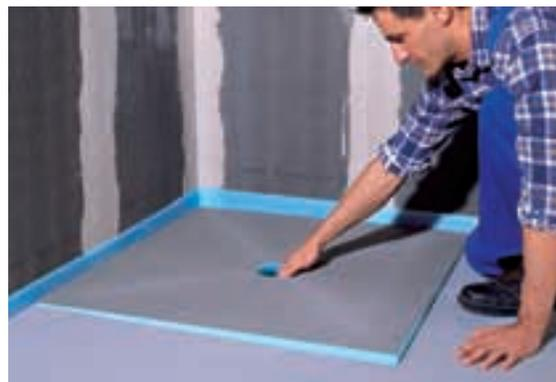
• wedi Fundo podni element postaviti, pri čemu se zaptivni umetak podnog tuš elementa mora točno utisnuti u kućište donjeg dijela odvoda. Provjeriti vodoravni položaj. Tokom otvrdnjavanja XFIX podloge element ravnomjerno opteretiti.
