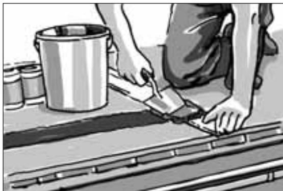
Nakon otvrdnjavanja ljepila ispod ploča BA Balco, spojna mjesta „Balco/Balco” i „zid/Balco” zaptivaju se pomoću posebnog za to predviđenog kompleta za zaptivanje BA Balco (zaptivna traka i zaptivna masa).
