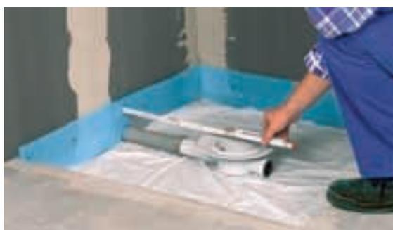
• U odgovarajući otvor u estrihu postavite donji dio odvoda i pomoću cijevi odgovarajuće dužine priključite na postojeću odvodnu cijev. Kod okomitog odvoda koji prolazi kroz ploču, se pri tome mora zatvoriti preostala šupljina oko cijevi s cementnim estrihom.
