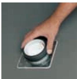
• Zaptivni umetak pritisnite ispod metalne ploče podnog elementa Fundo i ...
