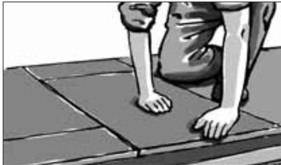
Ploče BA Balco položite na sloj ljepila te ih horizontalnim pomjeranjem u različitim smjerovima namjestite da leže punom površinom u ljepilu.
