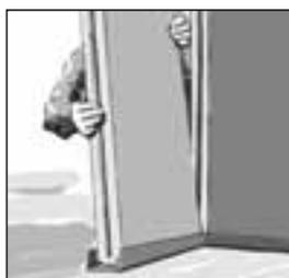
Stavite elemente pregradnog zida u ugrađene U-profile.
