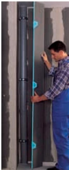
Taj tvornički prethodno uređeni kreativni kutni element iz osnovnog materijala ploče wedi BA debljine 20 mm je odličan nosač pločica i žbuke. Radi svog obostranog armiranog oslojavanja se pokazuje kao posebno otporan na lomove i deformacije.
