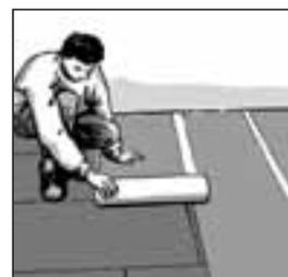
Na podložne tanjuriće i na spojeve stavite zaptivnu traku. **Preporuka:** Stavite kompletno traku za armiranje.
