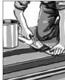
Nakon otvrdnjavanja ljepila ispod ploča BA Balco, spojna mjesta „Balco/Balco“ i „zid/Balco“ zaptivaju se pomoću posebnog za to predviđenog kompleta za zaptivanje BA Balco (zaptivna traka i zaptivna masa).
