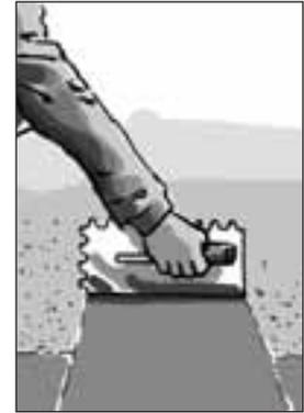
S glatkom stranom žlice za glačanje nanosite na podlogu tanki kontaktni sloj ljepila.
