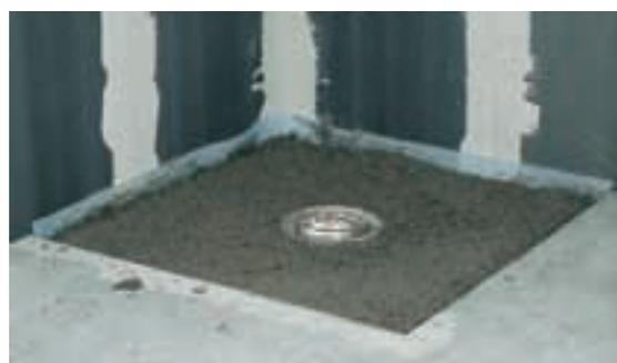
• Nakon ugradnje rubne trake za zvučnu izolaciju treba u pripremljeni otvor u estrihu nanijeti sredstvo za poravnavanje XFIX ili cem. estrih, propisno nabiti i poravnati na odgovarajućoj visini. Stavite još zaštitni poklopac kao zaštitu od prljavštine (za vrijeme gradnje) na kućište odvoda.
