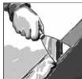
Za montažu krova nanosite epoksidno ljepilo na gornji rub zida.
