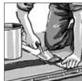
Nakon polaganja ploča BA Balco GP, spojna mjesta zaptivaju se pomoću posebnog za to predviđenog kompleta za zaptivanje BA Balco (zaptivna traka i zaptivna masa).
