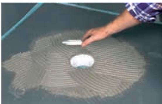
• Nadgradni element dovedite na debljinu pločica i stavite okvir za odvod.
